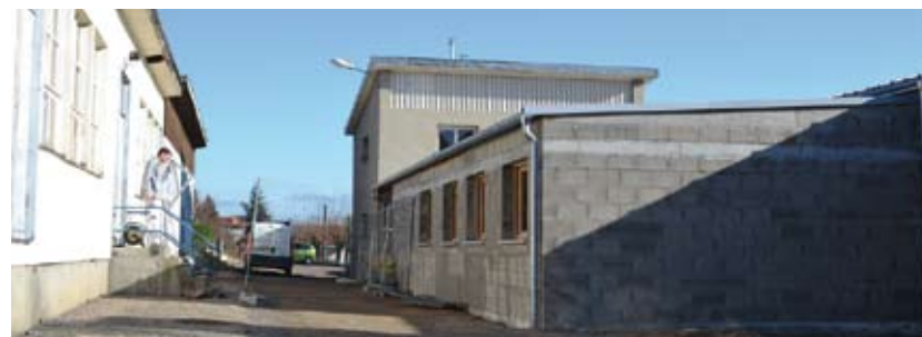
Les travaux d'extension de l'école sur la cour supérieure
