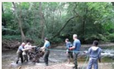
Travaux sur le Lignon
