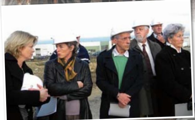
▲ Nouvel hôpital : visite de chantier
